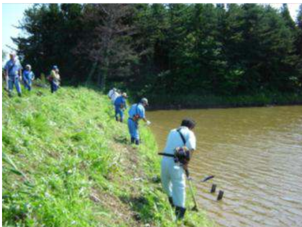
ため池堤体の草刈り
