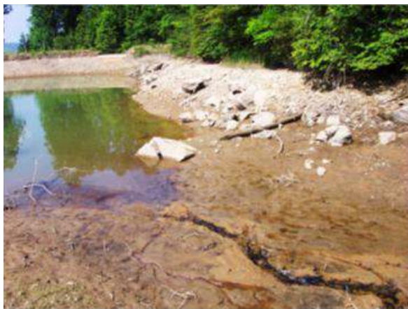
ため池に流入した土砂
