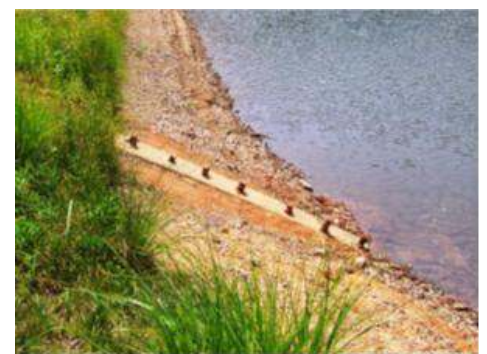
斜樋と取水栓
