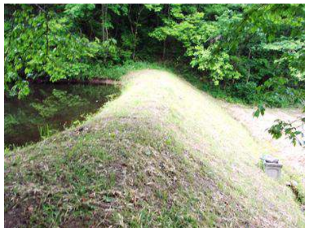
草刈りをしたため池堤体 (刈草の搬出後の状態)
