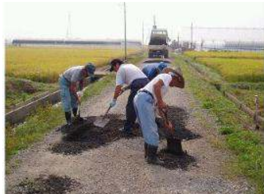
共同作業による砂利の敷き均し
