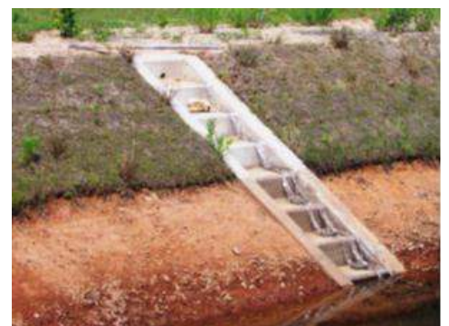
斜樋と取水栓（コンクリート製品）
