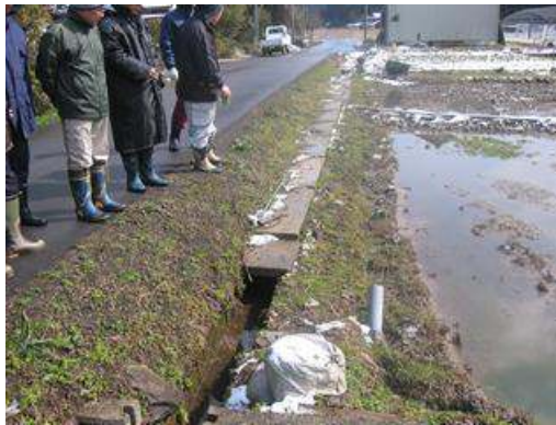
開水路の点検状況
